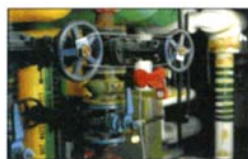
图2 用于锁定管道手轮阀门的锁具
